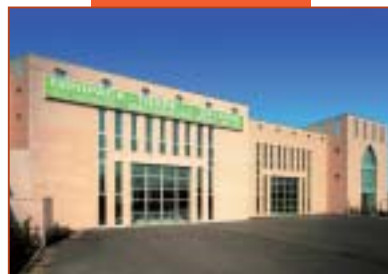
Plant n° 3 - Steel works - OSIO SOTTO
